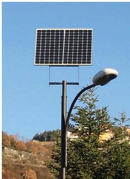
Il lampione fotovoltaico stradale è un sistema costituito da celle fotovoltaiche che convertono la radiazione luminosa diurna in energia elettrica accumulata durante il giorno per poi alimentare durante la notte la lampada al sodio bassa pressione.
